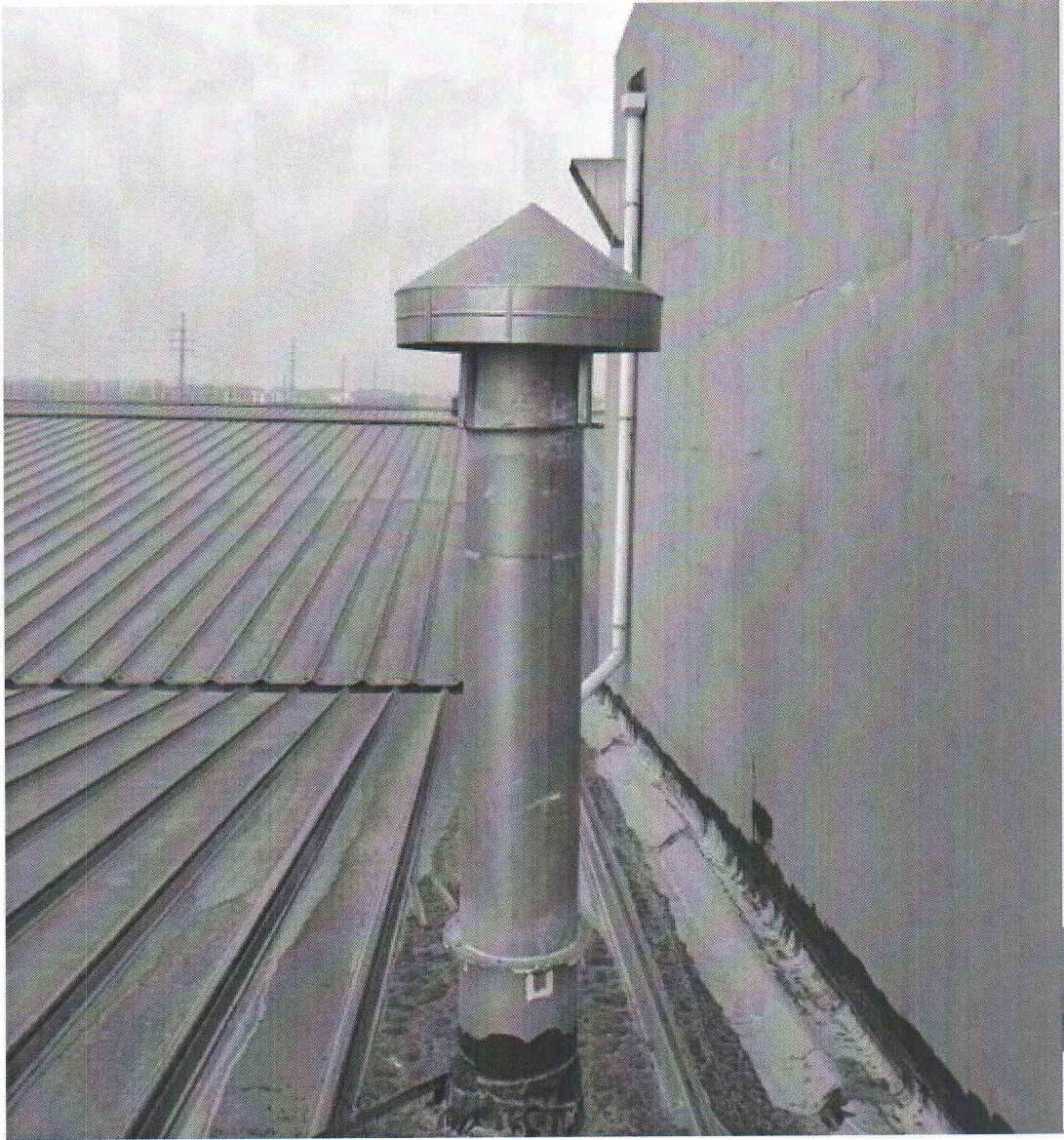
有组织废气排气筒
